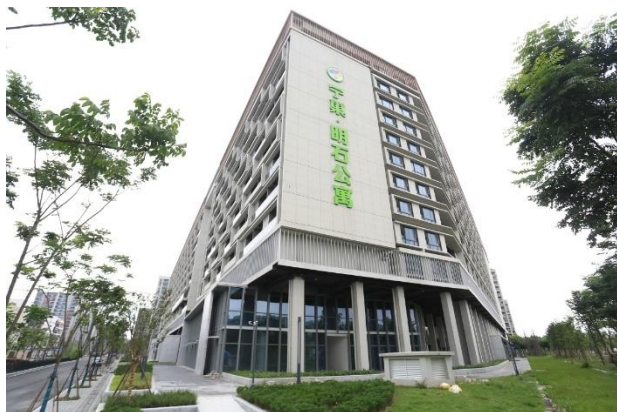
图 80: 杭州明石公寓项目实景图
