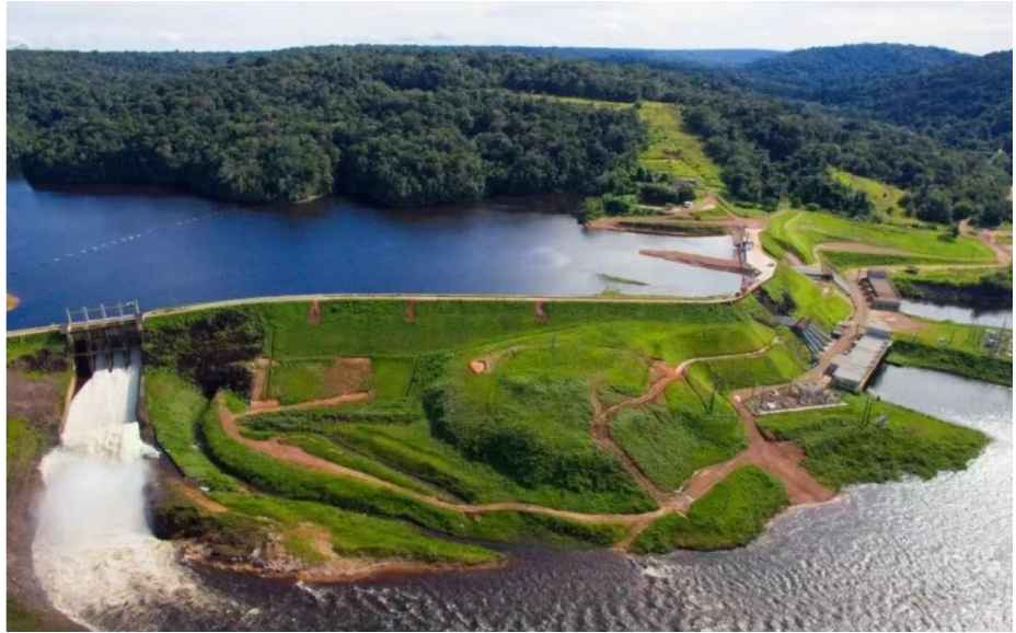
图表30: Taboca 矿山、冶炼厂及配套水电站
