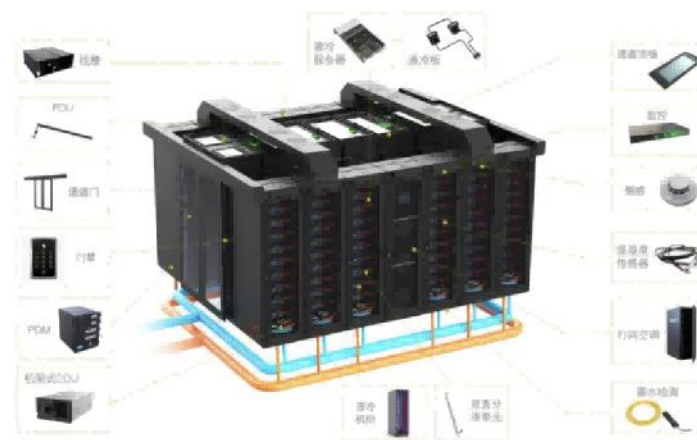
图6：冷板液冷微模块
