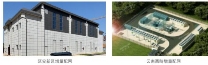
图21: 公司增量配网工程
