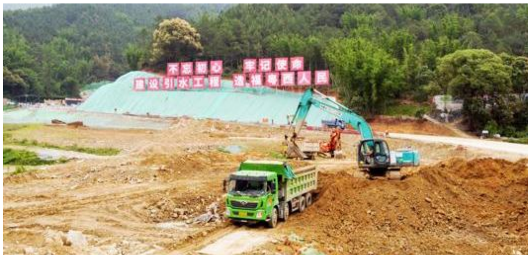
图 6：环北部湾广东水资源配置工程全线施工
