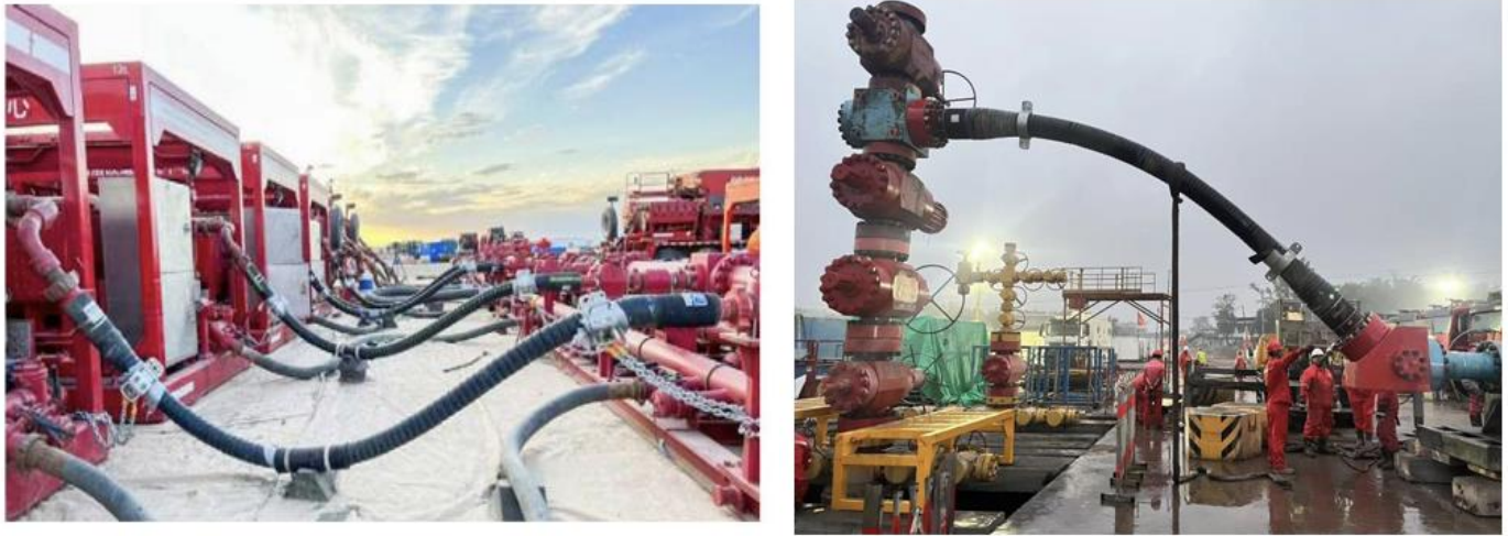
图5：酸化压裂高压软管应用现场
