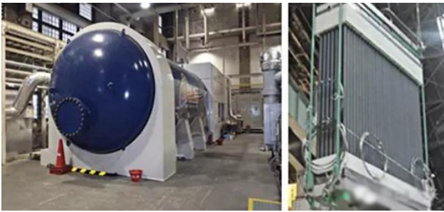
图11: 三菱重工 200kW 的 SOFC+MGT 复合发电系统
