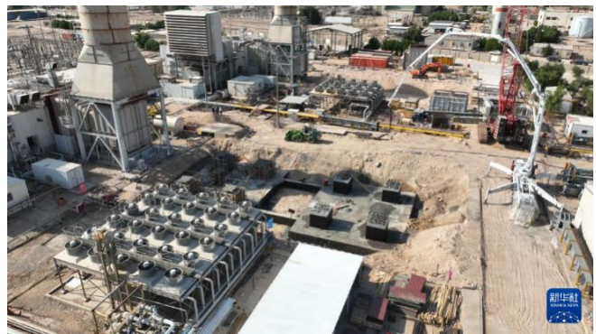
图34: 伊拉克纳杰夫燃机电厂联合循环扩建项目施工现场
