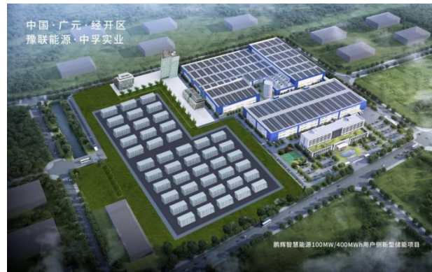
图 18：鹏辉智慧能源 100MW/400MWh 用户侧新型储能项目
