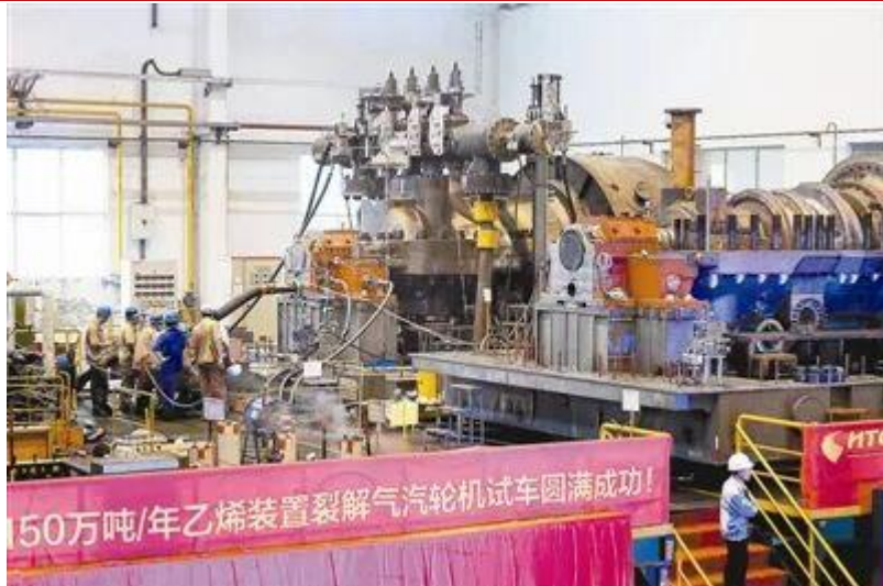
图表22: 150 万吨/年乙烯装置裂解气压缩机驱动用工业汽轮机试车成功
