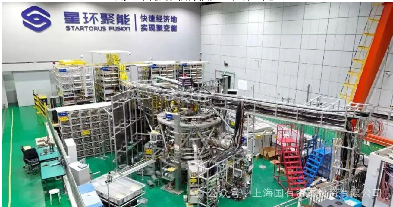
图：星环聚能可控核聚变实验基地建设正式通电
