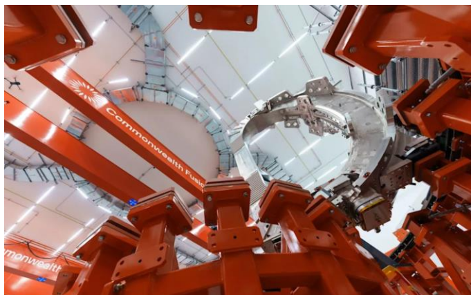
图17: CFS SPARC 装置首台磁体安装完成
