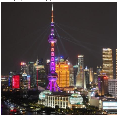
图21: 上海东方明珠广播电视塔
